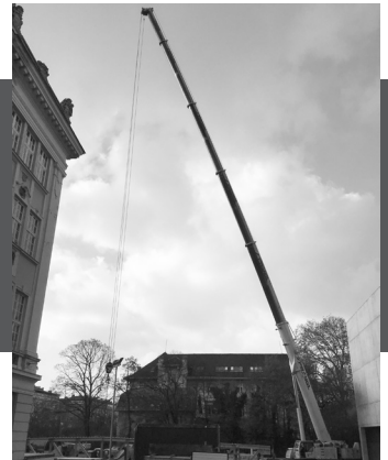
A speciális daru, amely a tetőelemeket emeli a helyükre. A hátsó elemek betételéhez egy gémet szereltek rá
